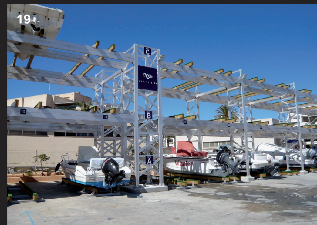
15 Marina Isla Valdecañas (Cáceres) 16 Port Ginesta (Barcelona) 17 Port Olímpic de Barcelona 18 RCN Gran Canaria 19 Dry storage (Ibiza)
